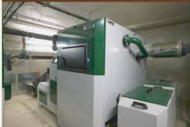
A dalt, la piscina coberta. A baix, les calderes.
