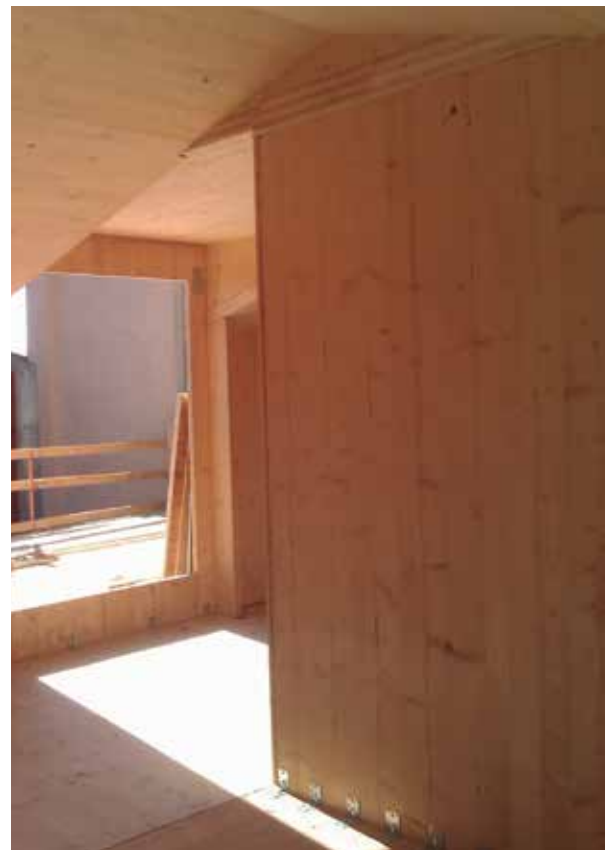
Fotografia 2. Interior amb paret de CLT.
