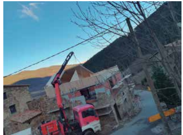
Fotografia 3. Remunta d'una casa amb FLX de Sebastia a Neva. Arquitecte Toni Codina
