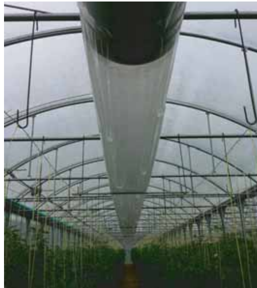
Fotografia 2. Hivernacle de cultiu de tomata amb distribució de calefacció per aire calent amb tub galvanitzat i tub de polietilè perforat.
