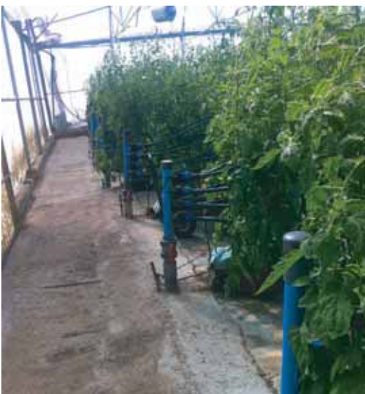
Fotografia 1. Hivernacle de cultiu de tomata amb distribució de calefacció per aigua calenta amb conducte de polietilè.
