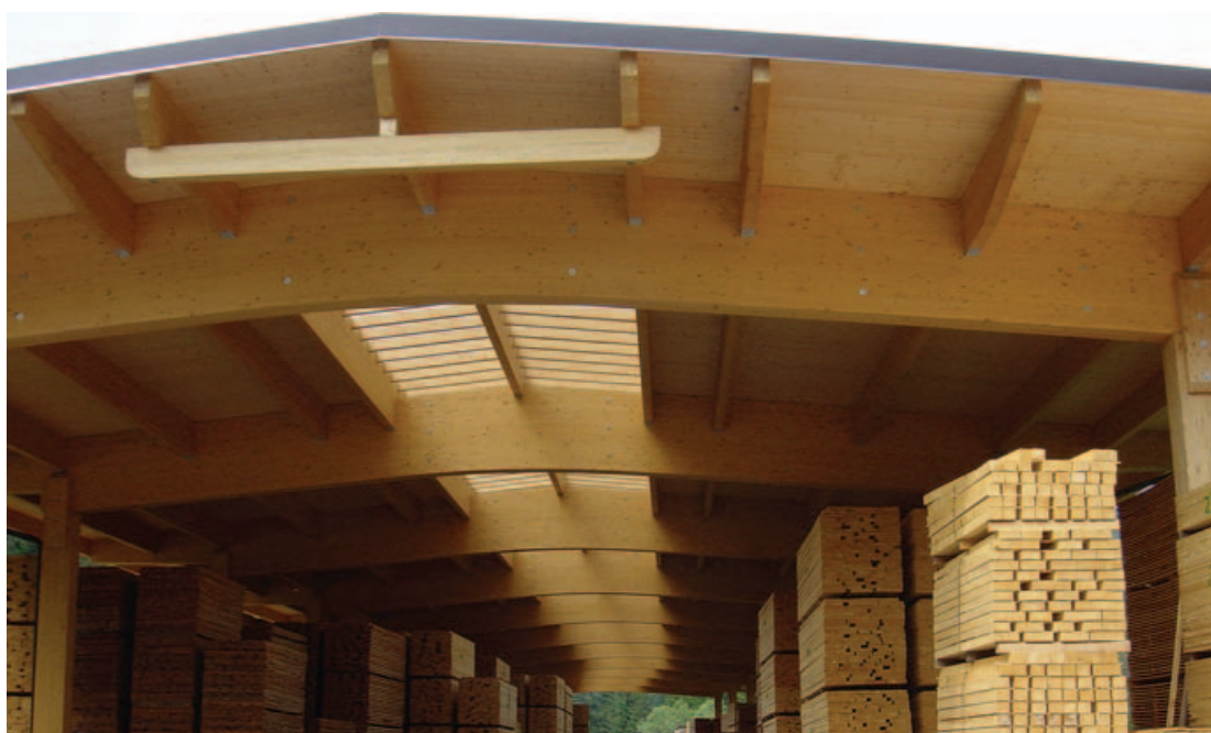
Foto: Magatzem de fusta d'una serradora construïda amb fusta laminada al nord d'Itàlia.
