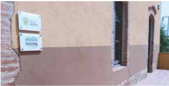
Fotografia 2. Rehabilitació de la façana de l'ICSuro amb suro projectat per Kliu Solutions. Font: ICSuro
