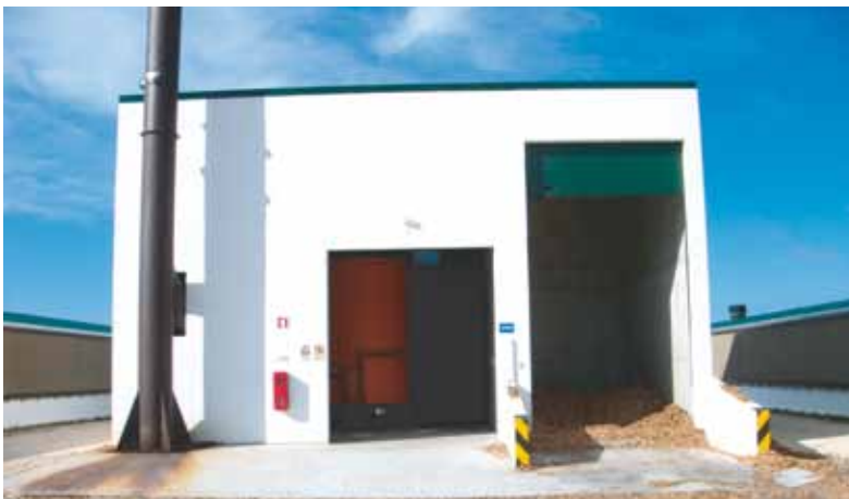
Fotografies 3 i 4. Caldera de biomassa i sala de caldera amb la sitja.
