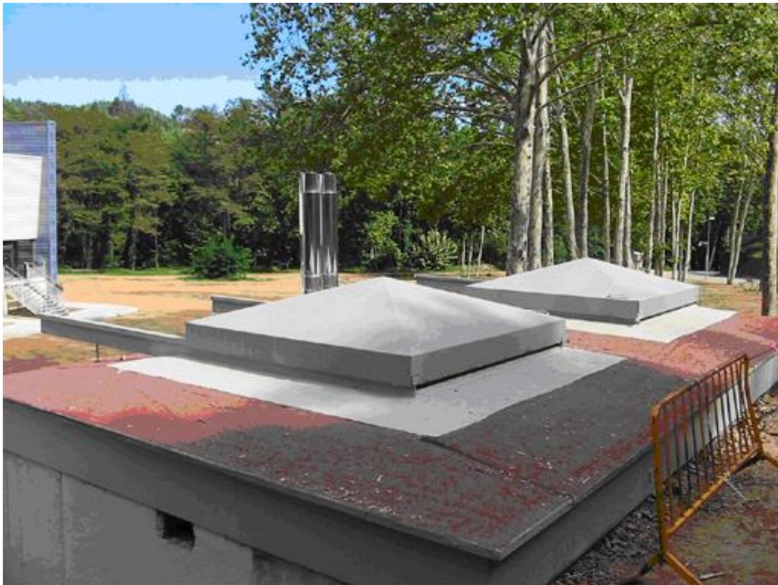
Fotografia 8: Part superior de les sitges de combustible.
