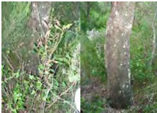
Fotografies 6 i 7. Preparació zona de treball.
